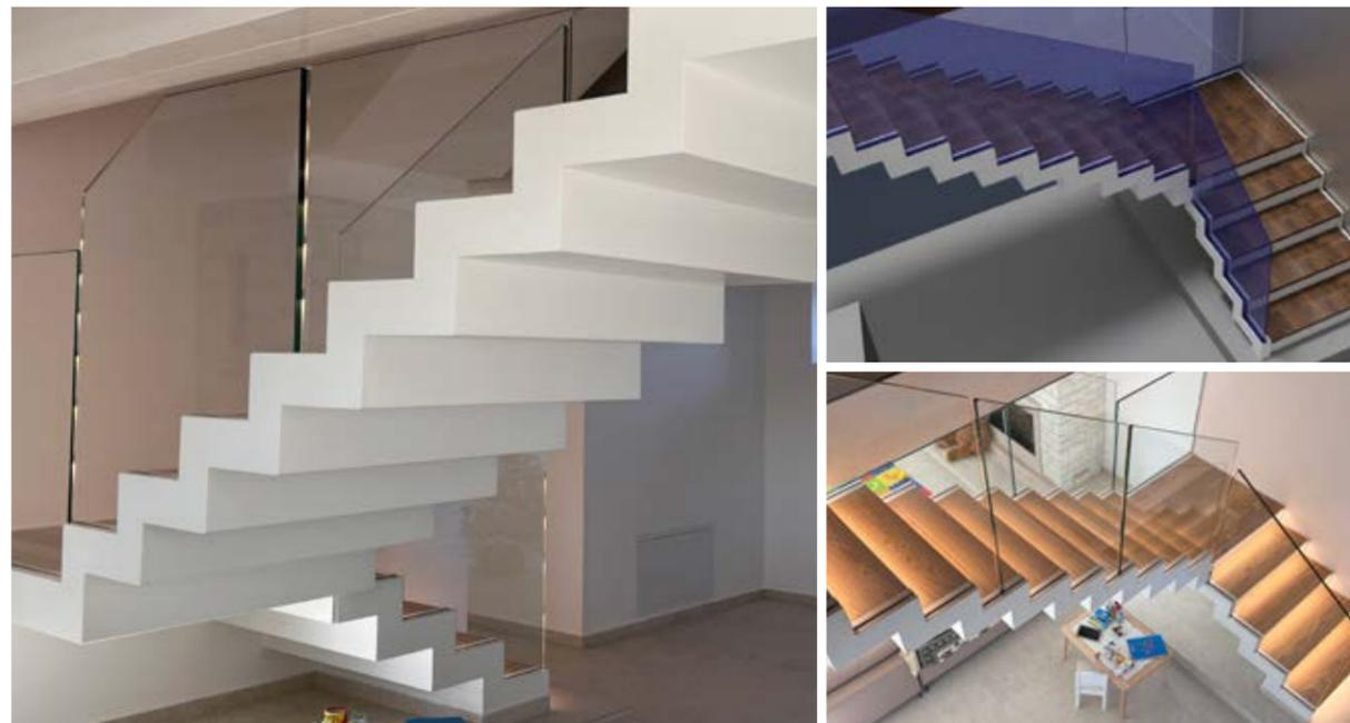
Scala monolitica in lamiera, siamo riusciti a nascondere tutti i fissaggi della struttura e della balaustra in vetro che sembra uscire direttamente dal cosciale in ferro. Al centro della sala della casa arricchisce l'ambiente rendendolo sofisticato.
