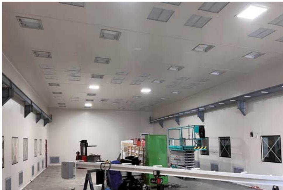
Struttura in carpenteria metallica per supporto tamponatura interna Camera bianca.
